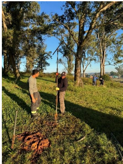
EXCAVACIÓN MEDIANTE PALA AMERICANA EN CATEO 6
