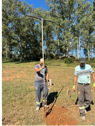
EXCAVACIÓN MEDIANTE PALA AMERICANA EN CATEO 3
