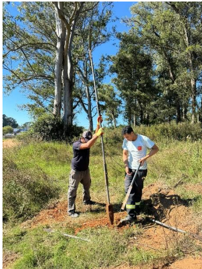
EXCAVACIÓN MEDIANTE PALA AMERICANA EN CATEO 2
