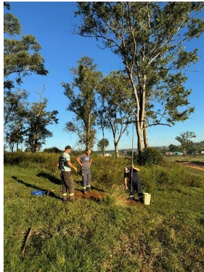
EXCAVACIÓN MEDIANTE PALA AMERICANA EN CATEO 4
